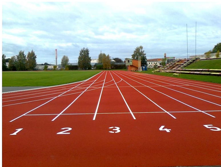
5.5.att. Stadions pēc rekonstrukcijas
