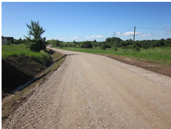
5.17.att. Rekonstruētais pašvaldības autoceļa „Tukums-Sveikuļi” posms
