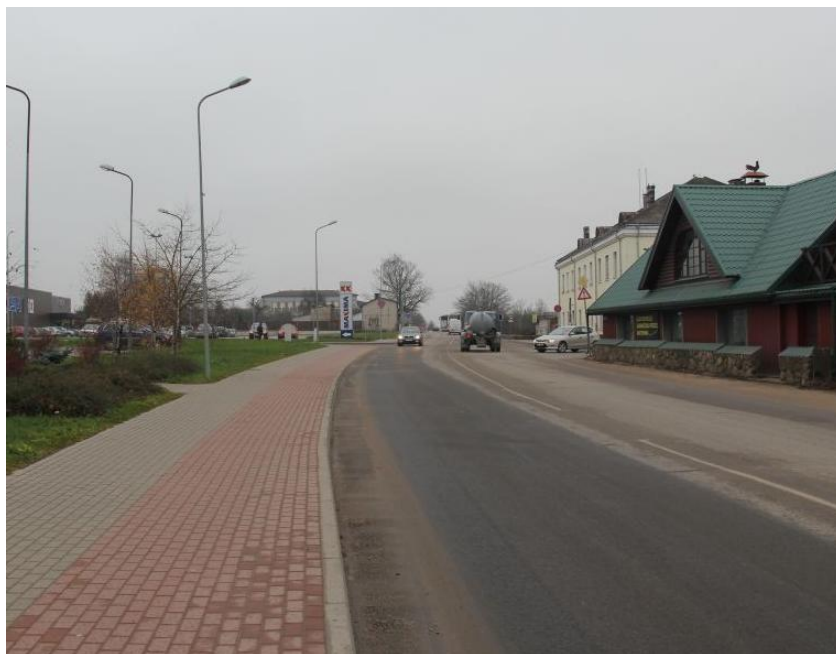
5.2.att. Kurzemes iela pēc siltumtīklu rekonstrukcijas
