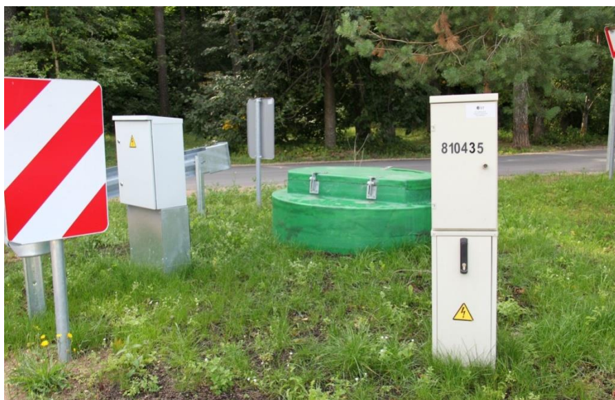
5.1.att. Ūdens un kanalizācijas tīklu izbūve Tukumā
