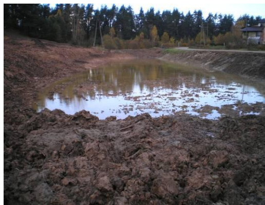
Pavārkalna dīķa gultnes tīrīšana
