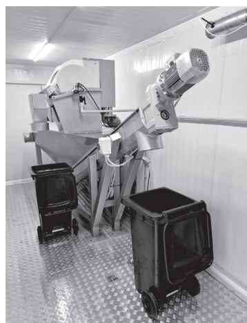
Iekārta, kas no saņemtajiem asenizācijas notekūdeņiem atdala rupjo frakciju un smiltis
