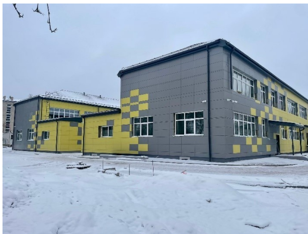
1.27. attēls. Energoefektivitātes paaugstināšana PII “Vālodzīte”.
