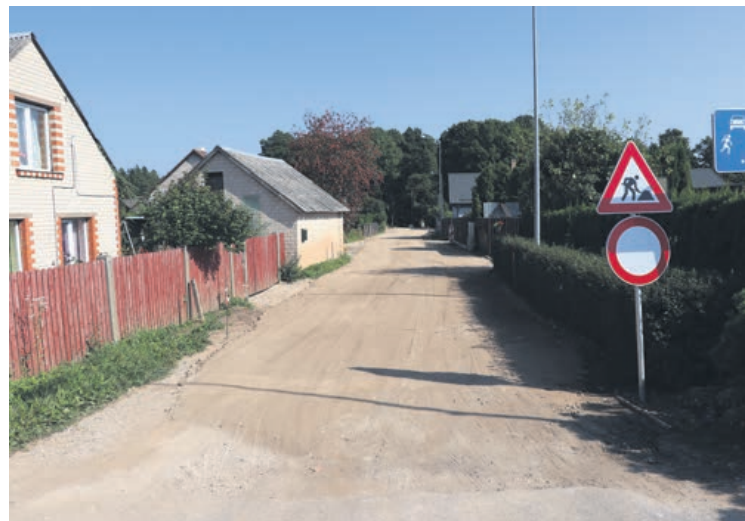
Būvdarbi Pīlādžu ielā, Tukumā
