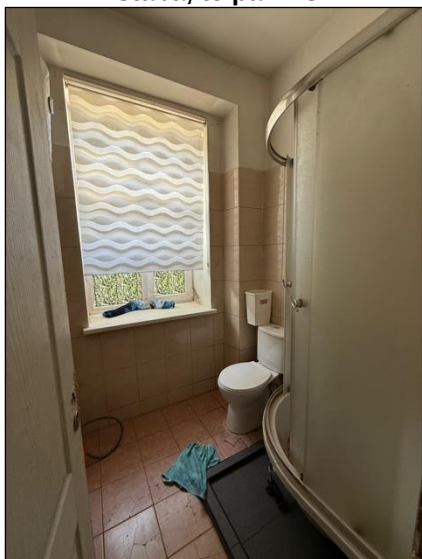
Izbūvēta sanitārtehniskā telpa, telpā nr.4
