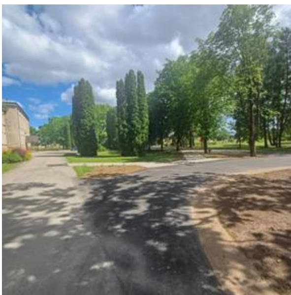
3.37. attēls. Izbūvētais autobusa apgriešanās ceļš pie Džūkstes skolas
