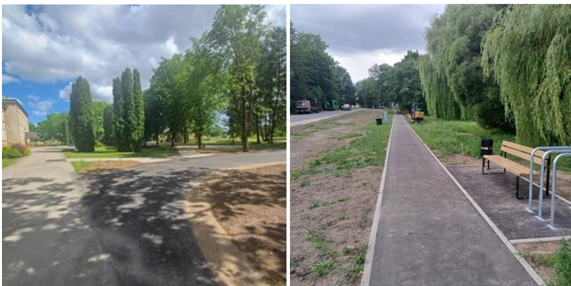
1.25. un 1.26. attēls. Izbūvētais autobusu apgrīšanās ceļš Džūkstē un gājēju celiņš Slampē
