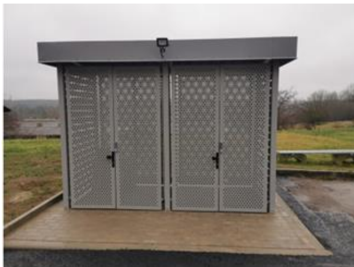
1.37. attēls. Atkritumu konteineru novietne Celtnieku ielā 3, Tukumā
