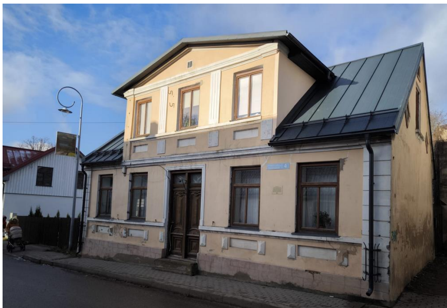
3.30.attēls. Nomainītais jumts Harmonijas ielā 4, Tukumā
