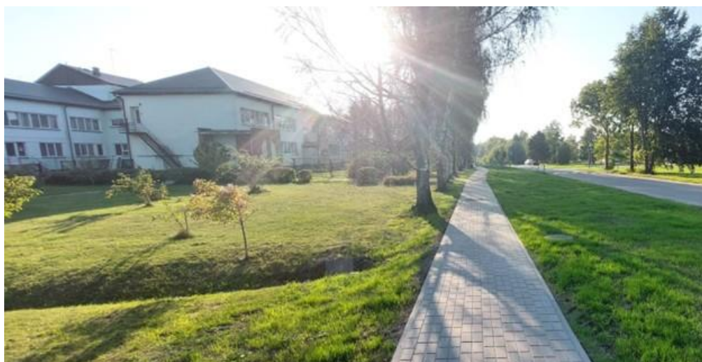
1.27. attēls. Izbūvētā gājēju ietve Skolas ielā Zantē
