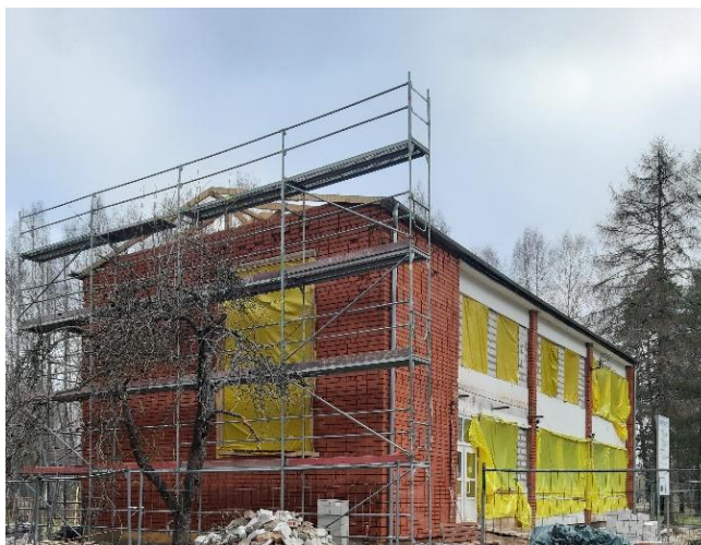
1.13. attēls. Ēka “Bērzi” būvdarbu laikā
