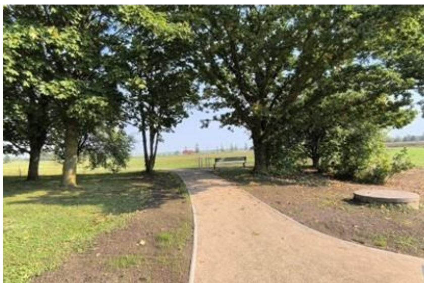
1.20. attēls. Izveidotais gājēju celiņš Slampes parkā
