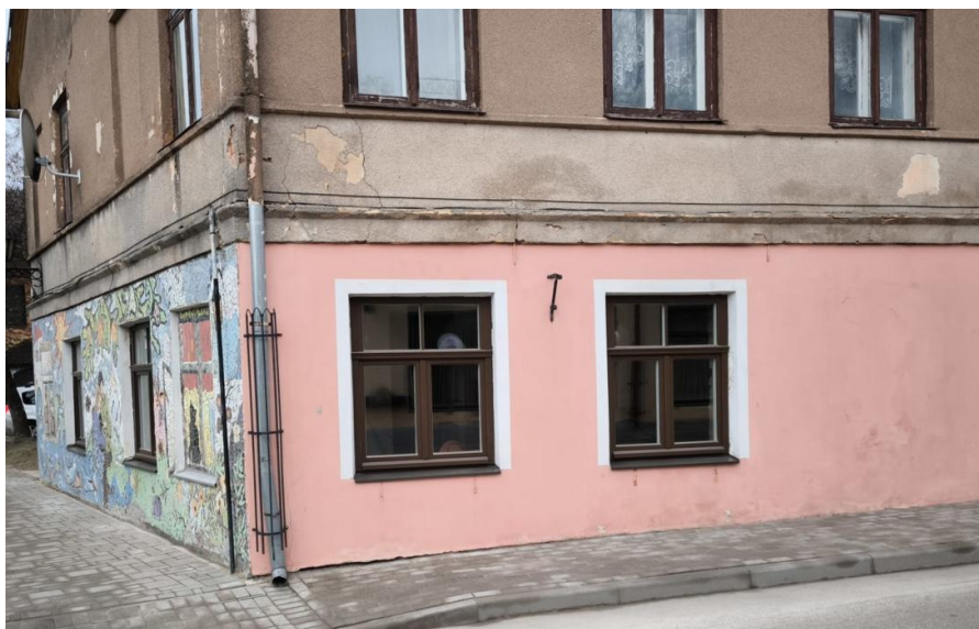
3.31.attēls. Nomainītie logi Lielā ielā 25-4, Kandavā (1.stāvs)
