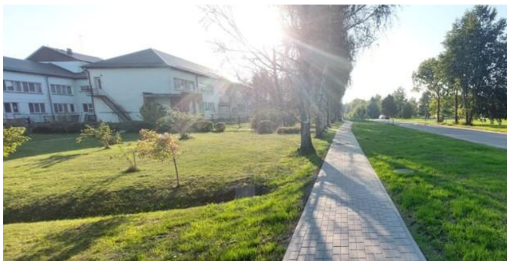
1.27. attēls. Izbūvētā gājēju ietve Skolas ielā Zantē
