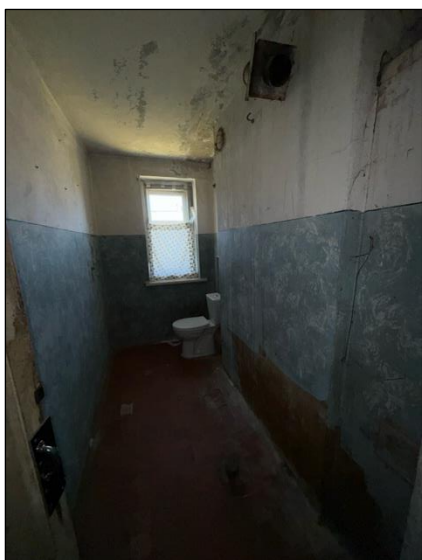
Sanitārā telpa, telpa nr.6
