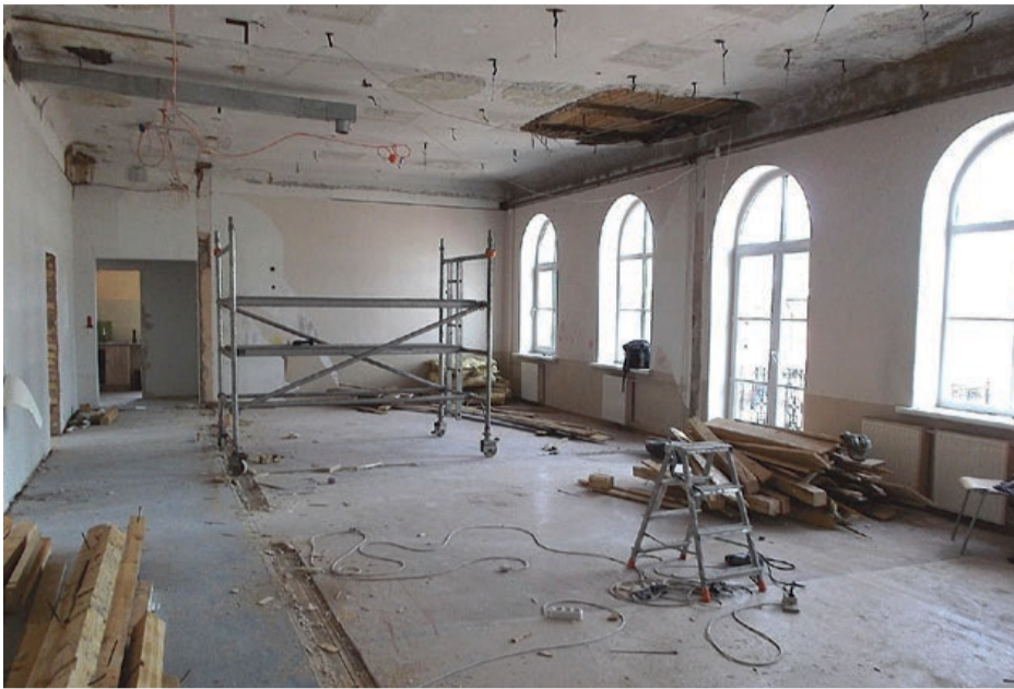
Tukuma 3. pamatskolas ēkas vienkāršotās pārbūves būvdarbu veikšana
