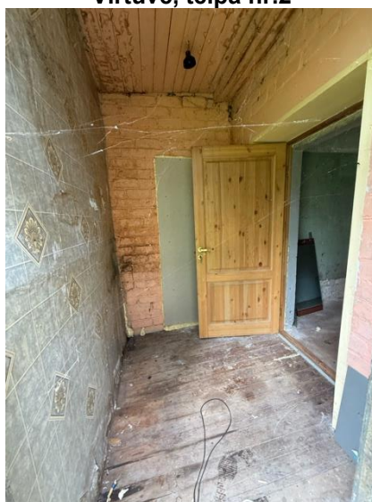
Priekštelpa, telpa nr.4
