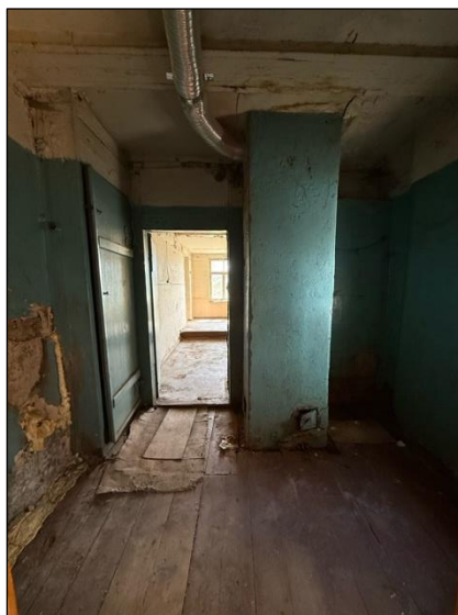
Palīgtelpa, telpa nr.6
