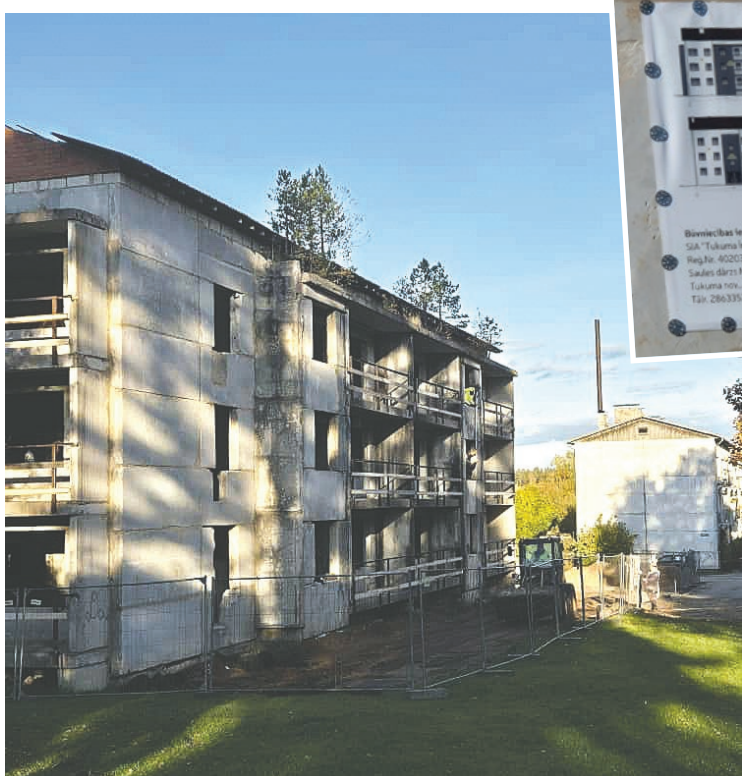
Būvniecība Ezera ielā 6, Sēmē
