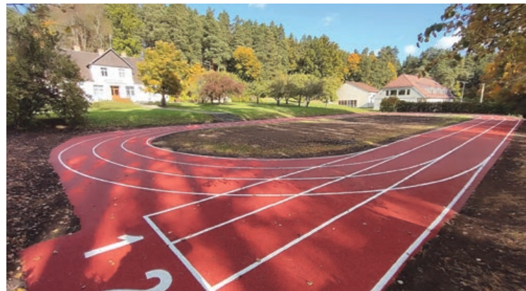
Milzkalnes sākumskolas rekonstruētais stadions
