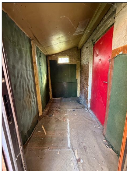
Priekštelpa, telpa nr.3
