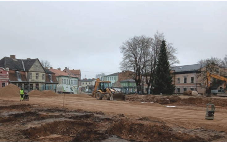
Brīvības laukums būvdarbu laikā
