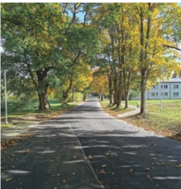
Pārbūvētais ceļa posms Irlavā
