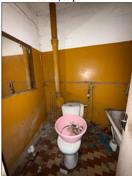
Sanitārais mezgls, telpa nr.3
