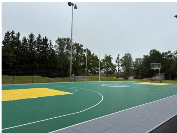
1.13. attēls. Izbūvētais basketbola laukums Zīļu ielā, Kandavā
