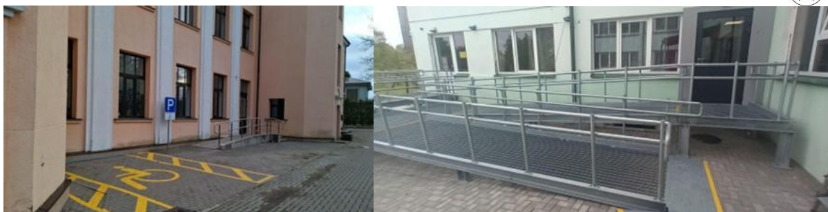
1.6. un 1.7. attēls. Veiktie vides pieejamības uzlabošanas darbi Skolas ielā 4, Zantē, un Zīļu ielā 2, Kandavā
