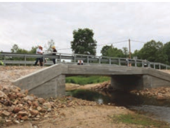
Pārbūvētais tilts. Foto: Liēna Trēde
