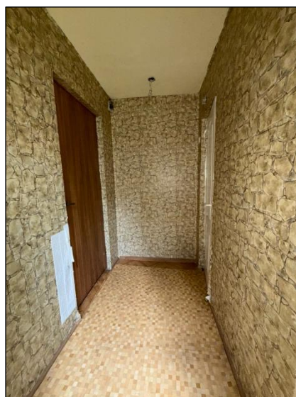
Priekštelpa, telpa nr.4
