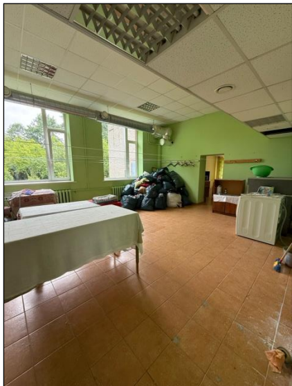
Telpa, katlu mājā
