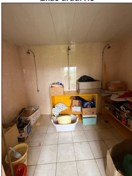
Telpa, katlu mājā
