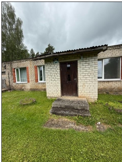
Ārdurvis nr.1 katlu mājai
