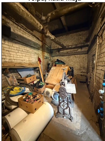
Telpa, katlu mājā
