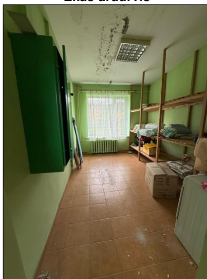
Telpa, katlu mājā
