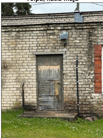
Ārdurvis nr.1 katlu mājai
