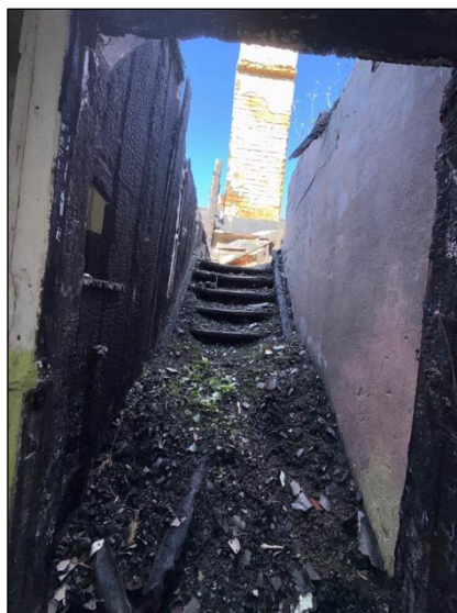
Trepes uz otro stāvu
