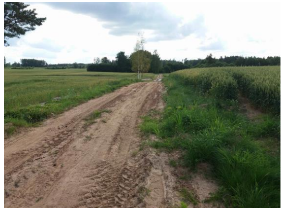
Autoceļa posms Cīruļi-Bērziņi pirms darbu uzsākšanas
