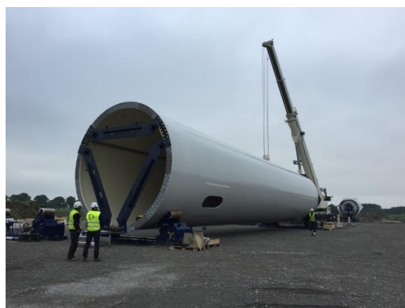
1.4. attēls. Vairāku segmentu VES masta posms (Vestas LDST; http://terralwind.com )
